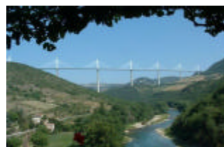
Viaduc de Millau
